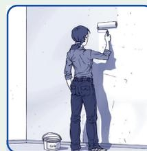
Appliquer une impression (sous-couche) sur les supports trop absorbants (enduits, plâtre, ...).
